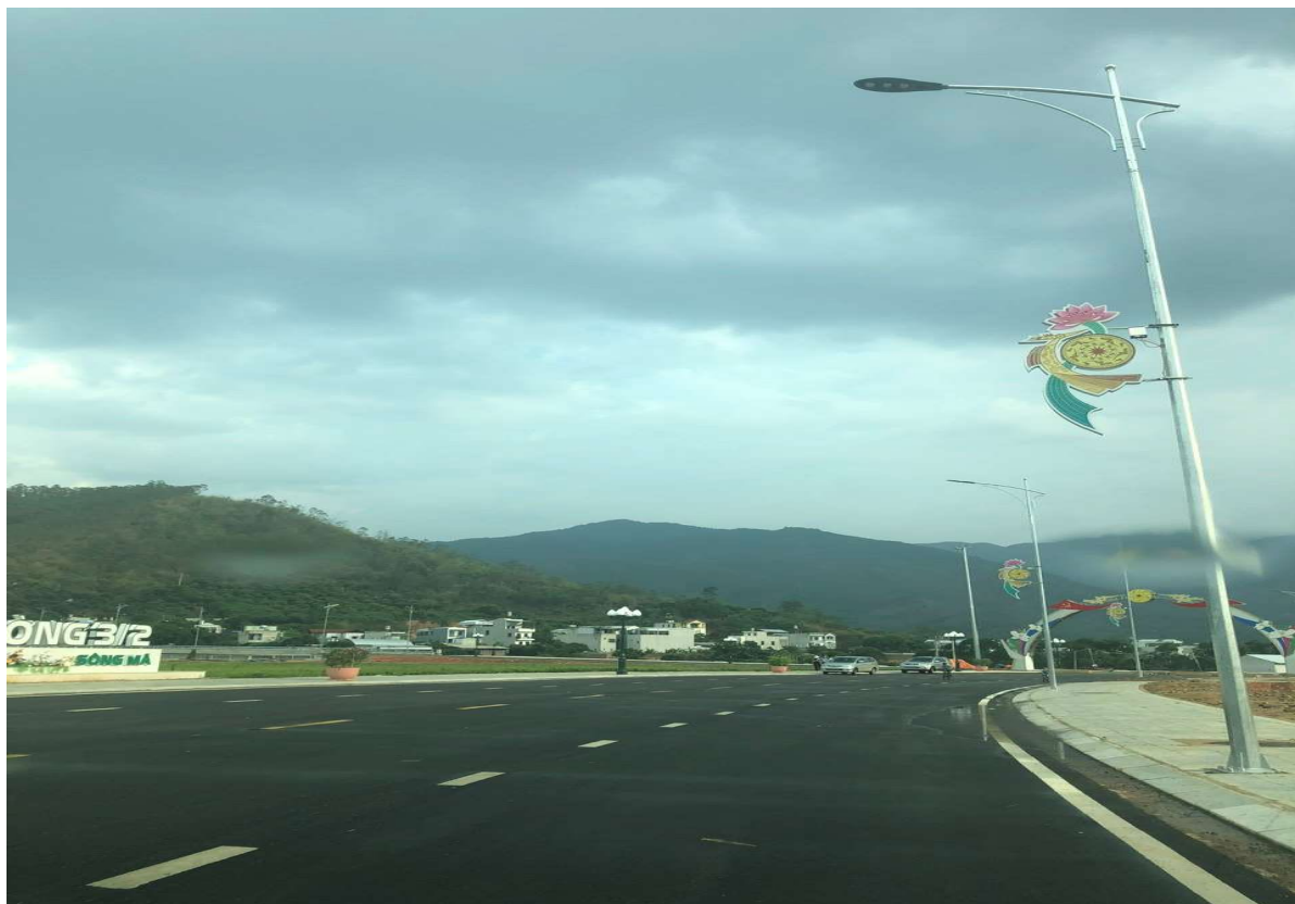
Hệ thống chiếu sáng tại đường Quảng Trường, thị trấn Sông Mã, huyện Sông Mã, tỉnh Sơn La
