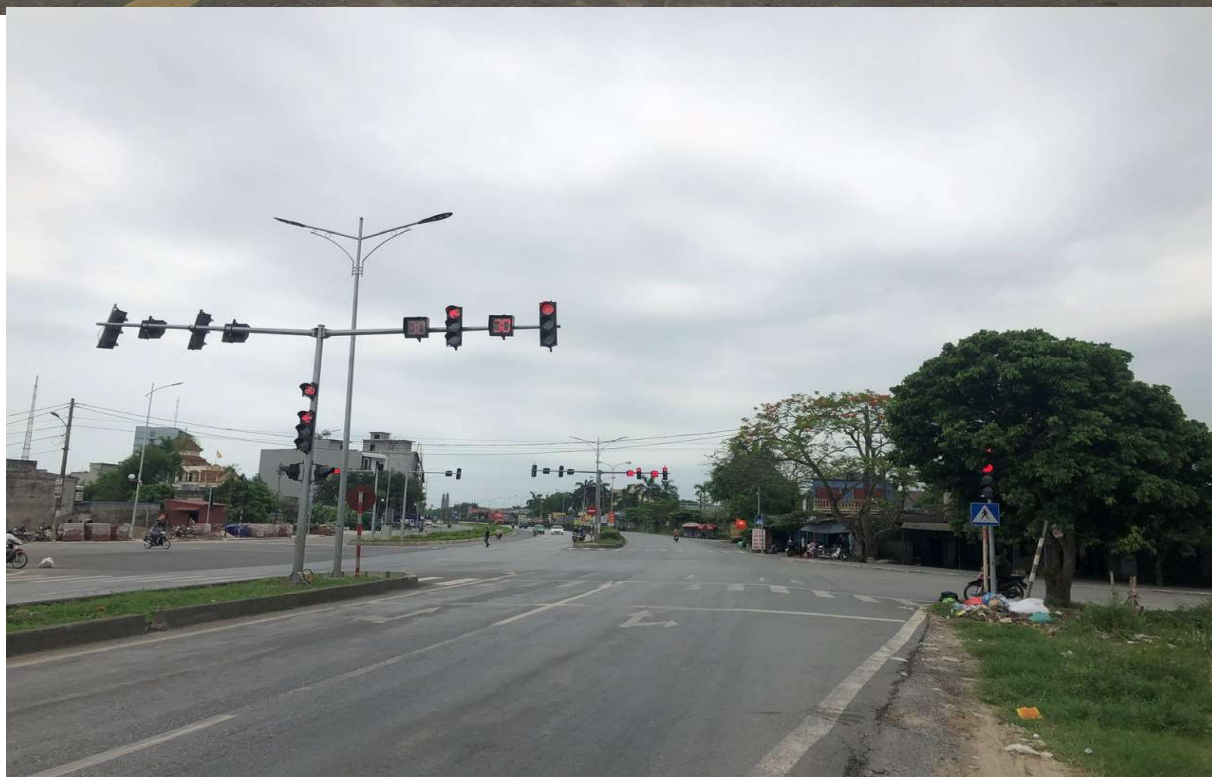
Cụm đèn tín hiệu giao thông tại Nút giao Quốc Lộ 10 giao với đường Trần Tự Khánh, TP. Nam Định, tỉnh Nam Định
